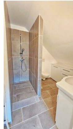
Zubau DG Bad/WC
