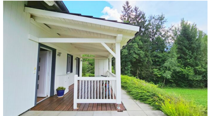
Zubau Eingang und überdachte Terrasse
